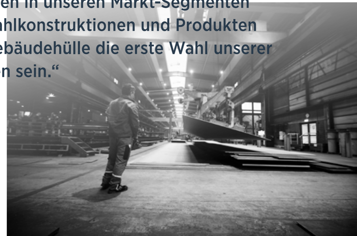
Fertigungsteile für eine Autobahnbrücke
